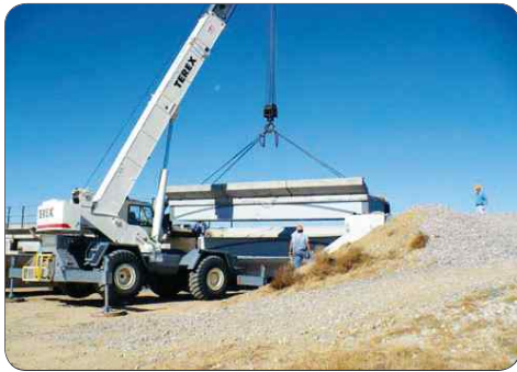
〈그림 4〉 Setting HCB Unit on Bridge Substructure
